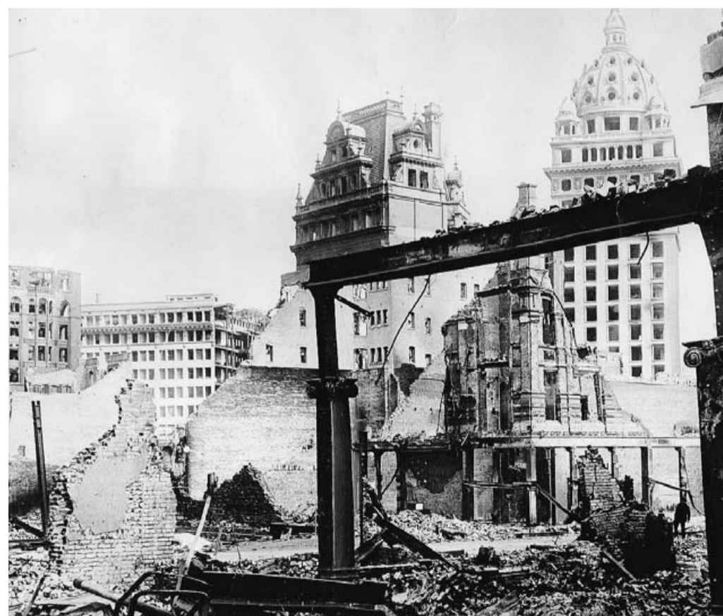
Macerie e travi annerite dal fuoco nella metropoli di San Francisco, nell'aprile del 1906
