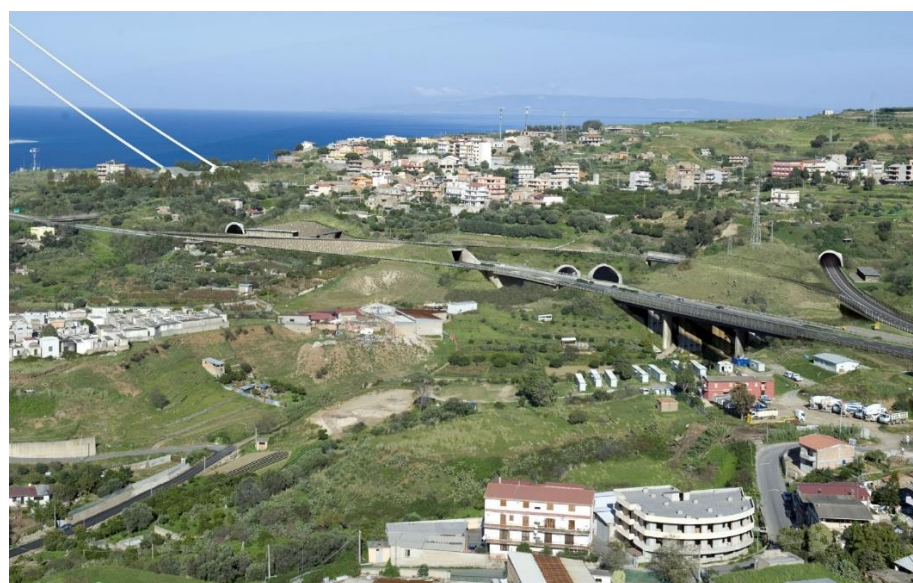
Figura 1-6 Fotoinserimento Versante Calabria (viste imbocchi galleria naturale Piave e rampe "D", "L" ed "M")
